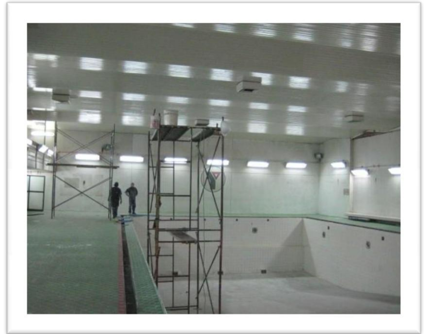
Instalación de faenas para pintura de cielo.
