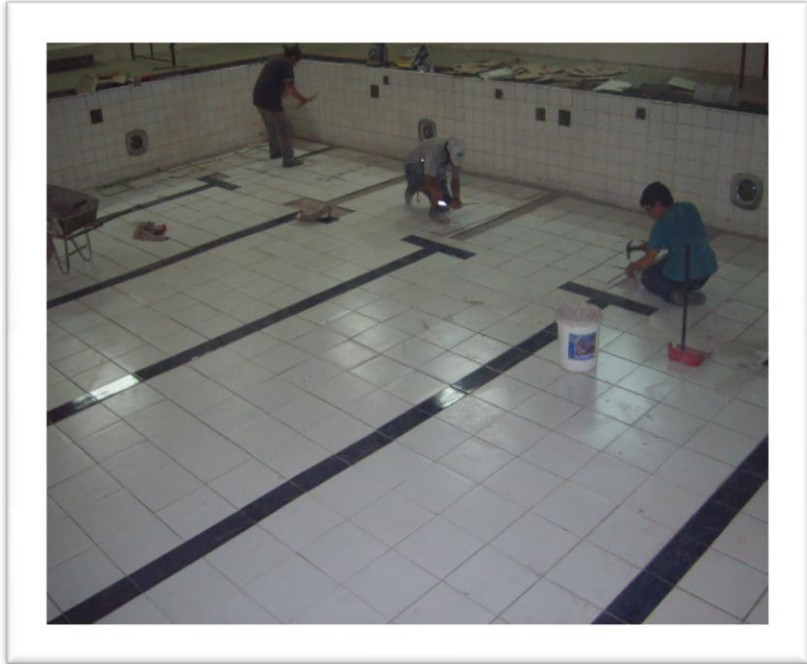
Obras de Instalación de cerámicos.
